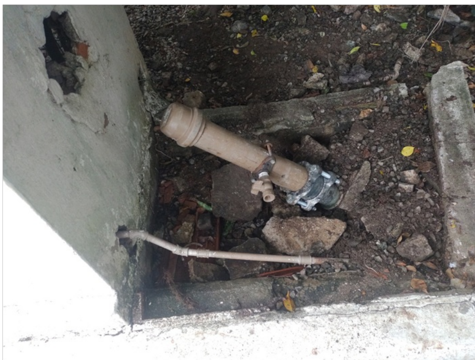
Foto 9 – Registro pós hidrômetro Sacadura Cabral
